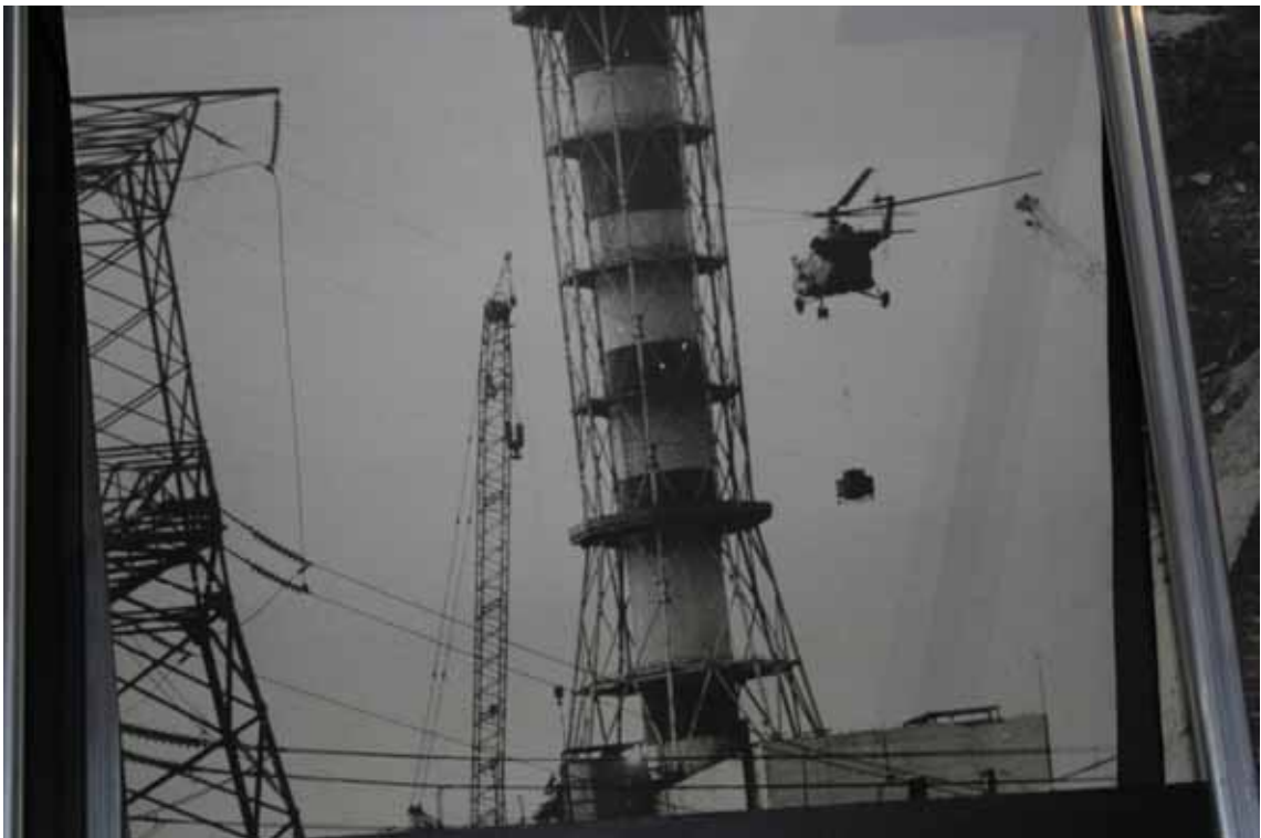
Een helikopter stort lood in de kernreactor
