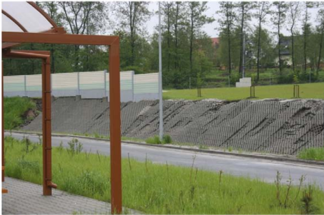
Onderweg langs de A4, de stenen waaronder het zand is weggespoeld
