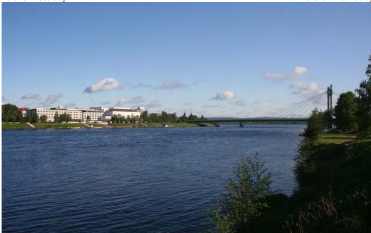
Rovaniemi nieuwe brug
