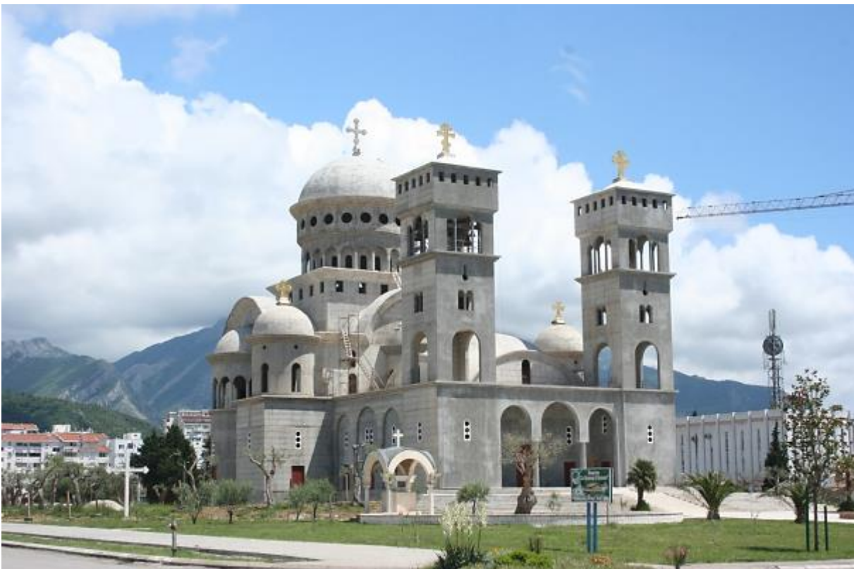
Een Oosters Katholieke kerk in aanbouw.
