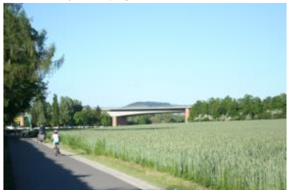
Brug over de Main, autobahn Frankfurt-Würzburg
