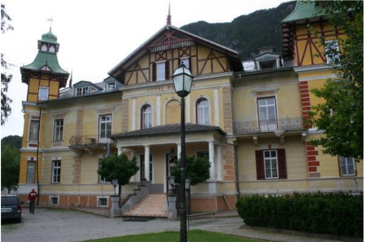
Hotel-Pension Amlacherhof is men aan het restaureren
