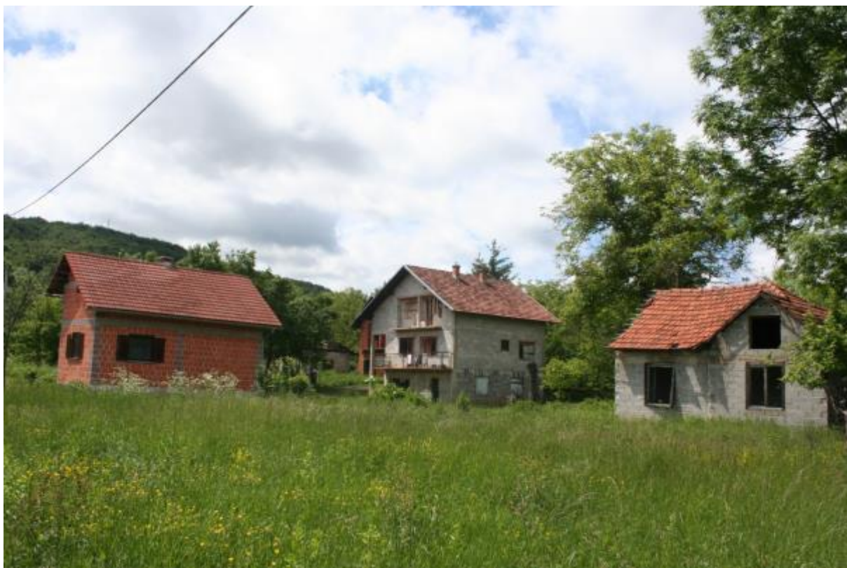
Woonhuizen in verschillende staat van afbouw
