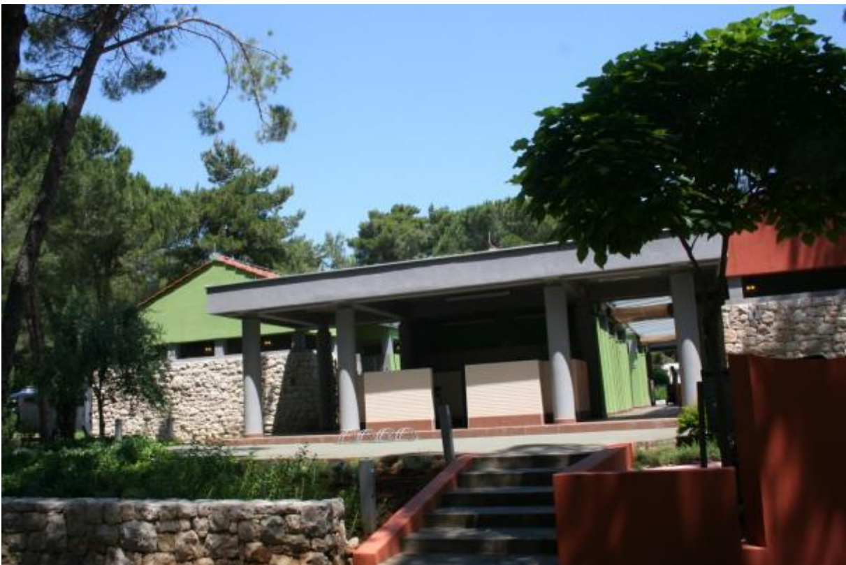
Ons uitzicht, het toiletgebouw
