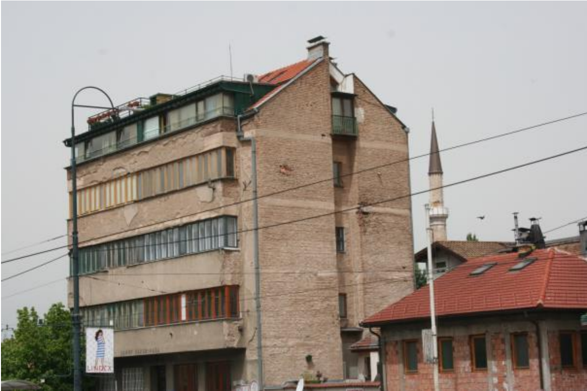
Hier is nog oorlogsschade te zien aan de muren
